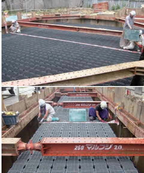
▲雨水貯留槽の設置作業の様子
