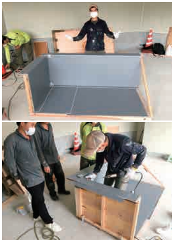
▲建築防水技術研修センターでの実習
