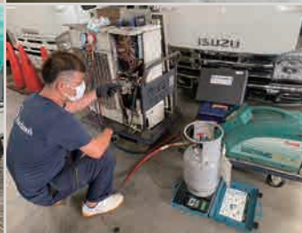
▲現場作業の様子
