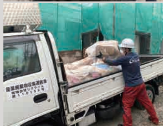
▲現場作業の様子
