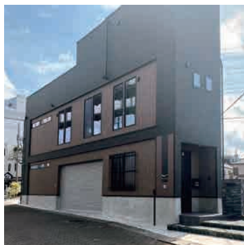
▲デザイン事務所のような外観。屋上にBBQエリアを作成中
