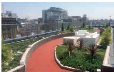
▲マンション屋上の緑化工事例
