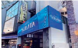
▲LEDビジョンの施工現場と仕上がり (渋谷区の宿泊施設)
