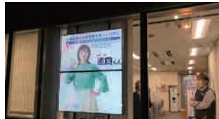
▲店舗の室内で、屋外へ向けてガラス越しに 設置された高輝度55型サイネージ
