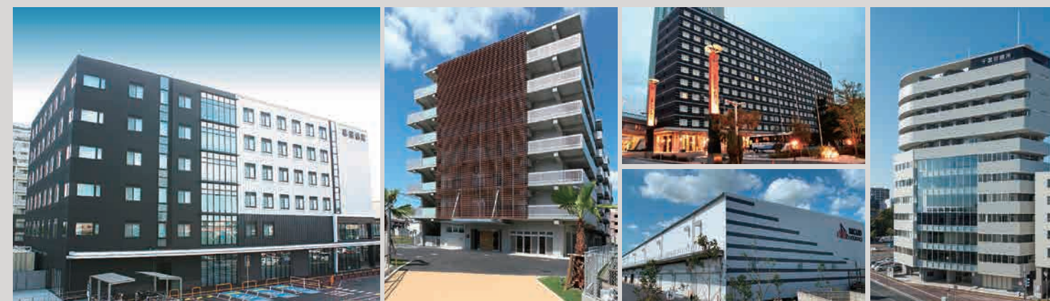
▲施工例(左から)白百合会幕張病院、特別養護老人ホームかなめ一輪荘、アパホテル&リゾート(東京ベイ幕張)WEST WING(写真上)、MCUD八千代(写真下)、(一社)千葉衛生福祉協会千葉診療所
