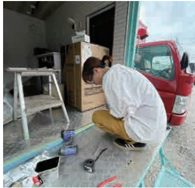
▲施工作業の様子
