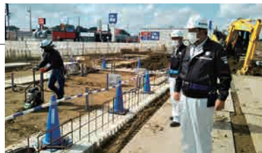
▲危険箇所や作業工程の確認をしながら、社長自ら各現場の安全状況をパトロール
