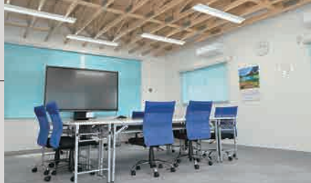
▲「PLUS ONE」の2階は研修などで使用。天井は木材の梁（トラス）を特殊な部材で固定し、耐震性能をアップした明るく開放的な空間
