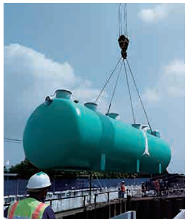
▲ベトナムでの浄化槽の設置現場
